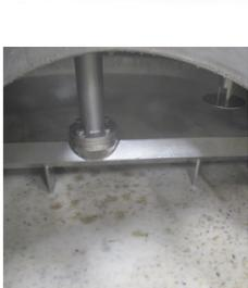
Le malt concassé est mélangé avec de l'eau chaude dans la **cuve d'empâtage (MM-LT)** pour former la **maïsche**. La maïsche dans la cuve est chauffée progressivement afin de créer des conditions optimales pour l'activation des enzymes qui décomposent l'amidon et le transforment en molécules de sucre simples et hydrosolubles. La température et le temps d'empâtage doivent être toujours contrôlés.
